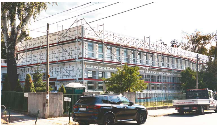
A Szent Korona utcai óvoda épülete
