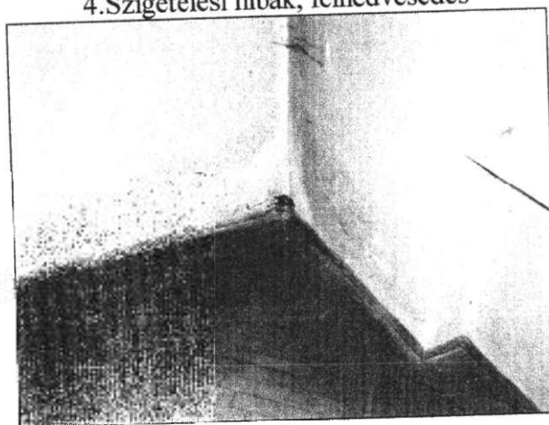
4.Szigetelési hibák, felnedvesedés
