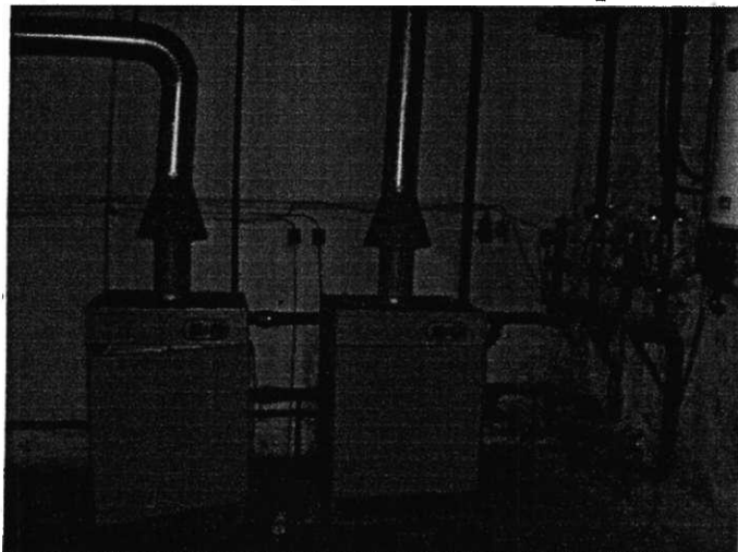
Az épület fűtését biztosító két gázkazán és a gázóra a pince előterében
