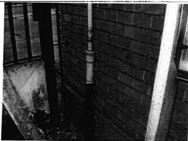
Az épületbe vezető villany és gáz becsatlakozások
