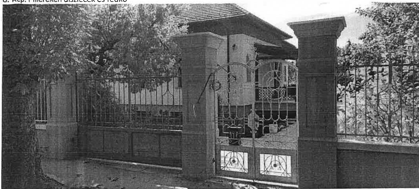
9. kép: Lábazat burkolása klinkerlapokkal
