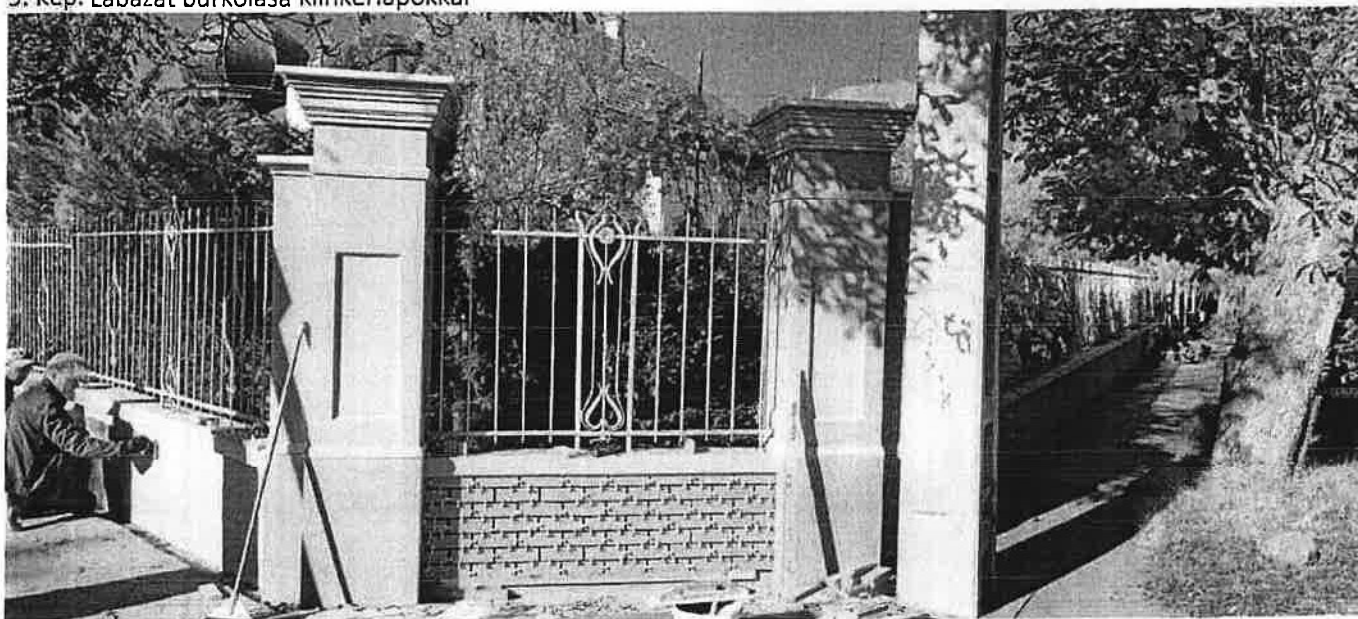
9. kép: Lábazat burkolása klinkerlapokkal
