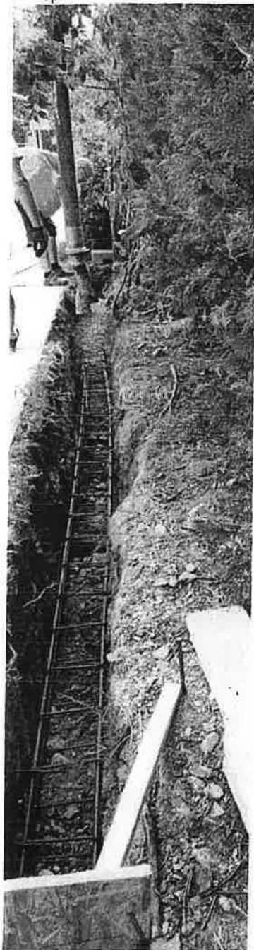
6. kép: Veres Péter úti oldalon alap vasalása, betonnal kiöntés
