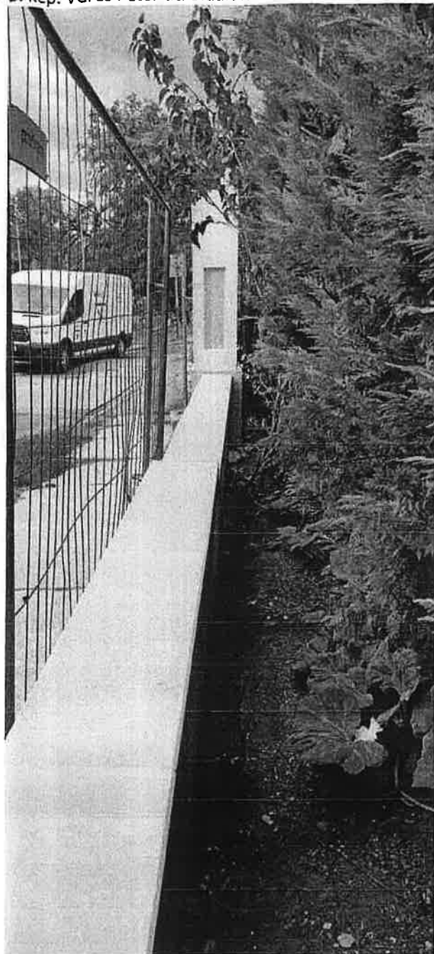
10. kép: Veres Péter úti oldalon felkerül a lábazatra a műkö fedlap
