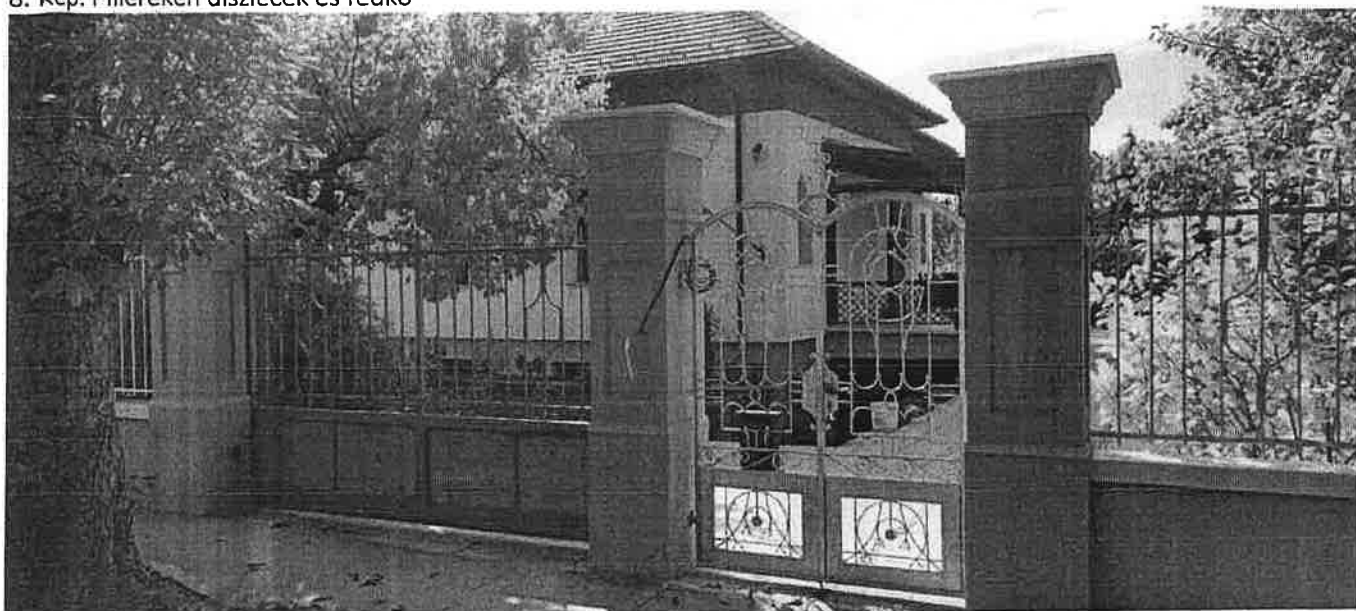
9. kép: Lábazat burkolása klinkerlapokkal
