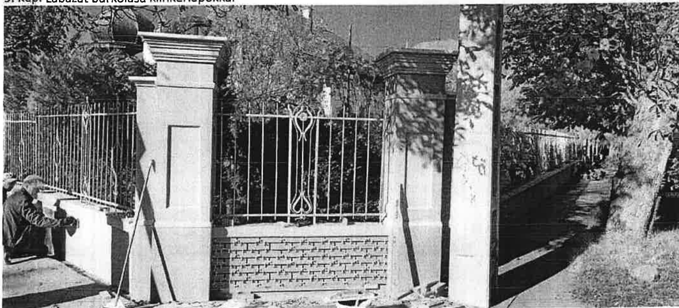
9. kép: Lábazat burkolása klinkerlapokkal
