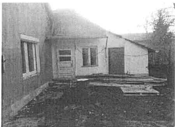
lakás bejárata és homlokzata
