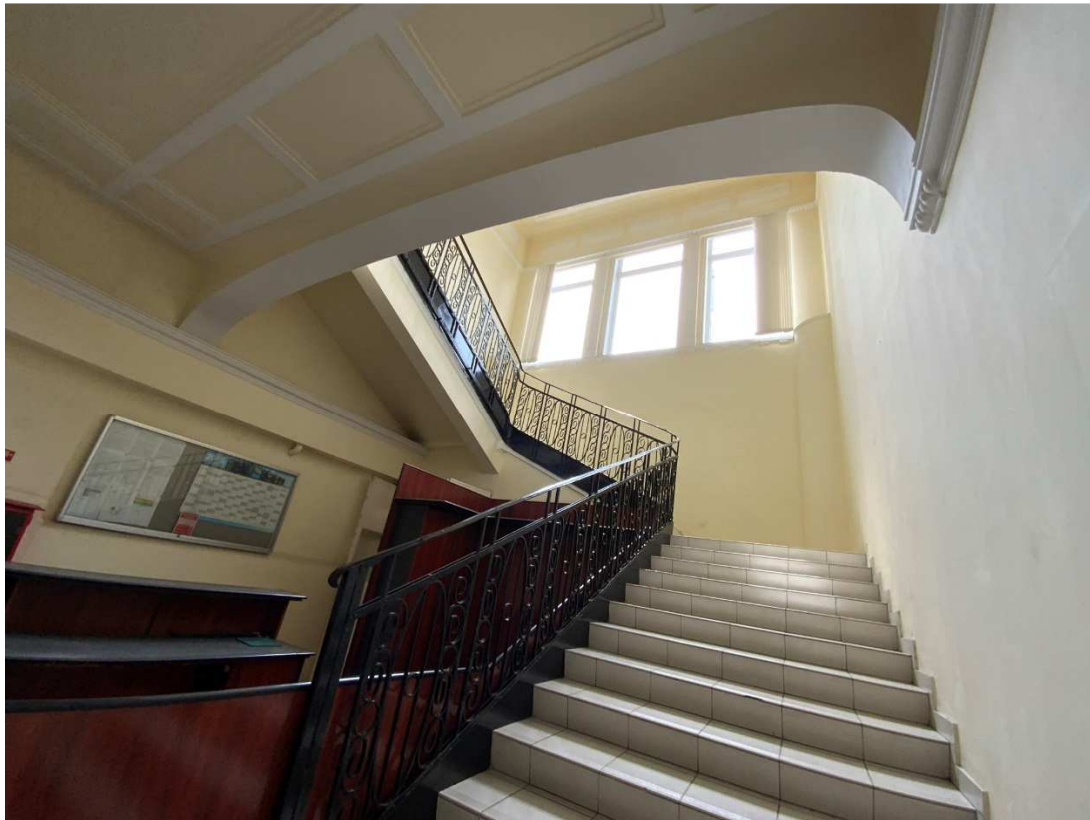
Az építészeti korlát jó állapotban látható
