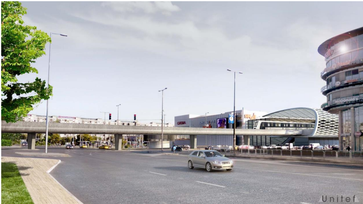
METRÓ MŰTÁRGY ÁTVEZETÉSE AZ ÖRS VEZÉR TERÉN
