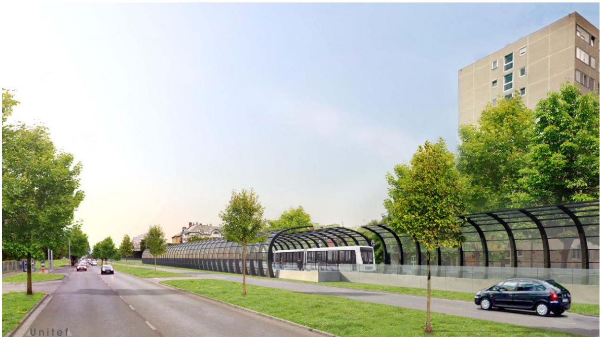
RÁKOSFALVA METRÓÁLLOMÁS ZAJVÉDŐ SZERKEZETEKEL ÉS ÉLETVÉDELMI KERÍTÉSSEL HATÁROLVA
