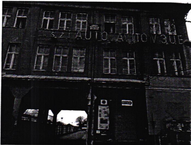
Főépület iroda homlokzat I.
