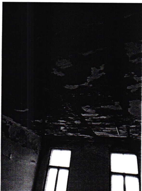
Főépület iroda belő III.
