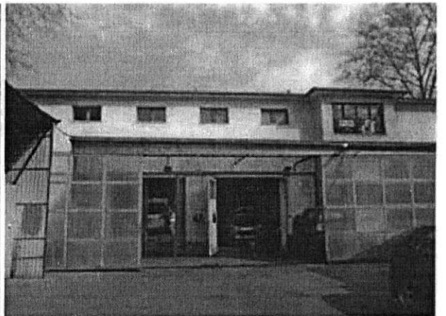
1. sz. épület, előtte a nem értékelt könnyűszerkezetes toldalék
