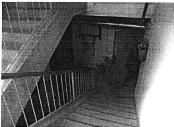
1. sz. épület, pincelejárát és gáz fogyasztásmérő
